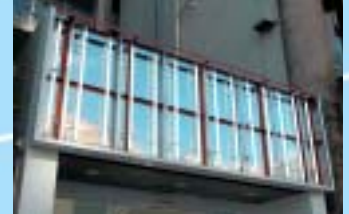
FEI-D40W 壁面看板の平付け内部
